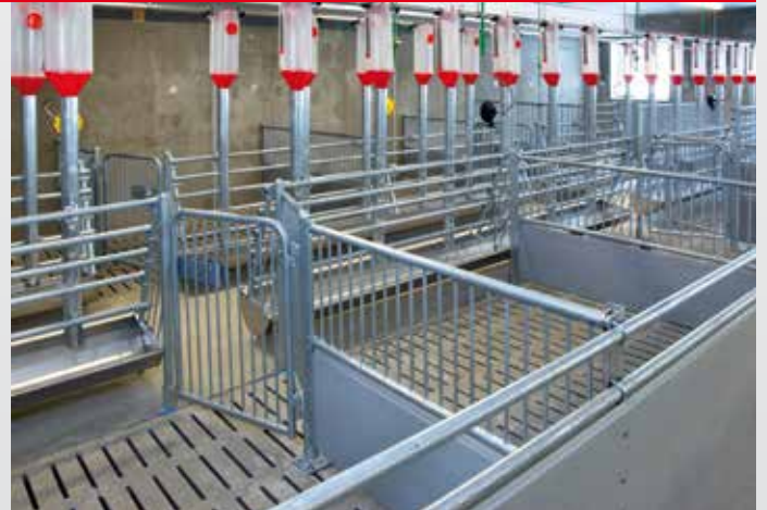
Sauenfressliegebucht für Deckzentrum mit hochklappbaren Türen, von hinten und vorne zu betätigen, mit Besamungstür
